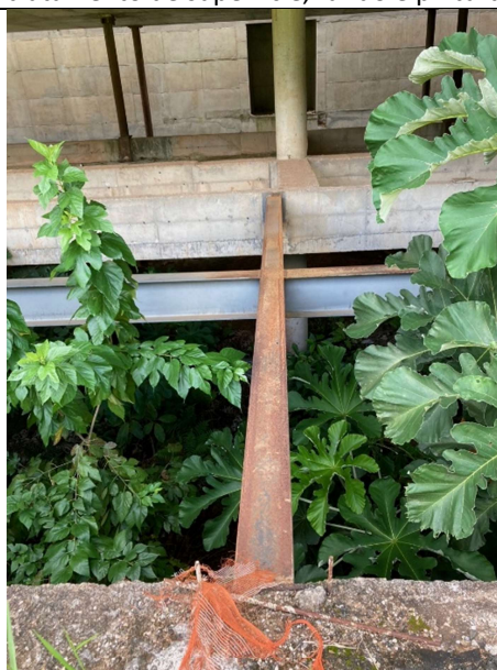
Ao fundo colunas de perfil circular que receberão tratamento e pintura
