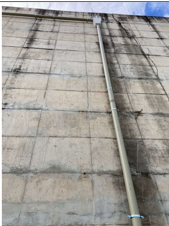
Tubulação a ser removida e reinstalada após tratamento das fissuras.
