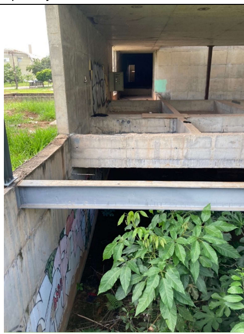
Vista do subsolo onde serão executadas as estacas tipo reação.
