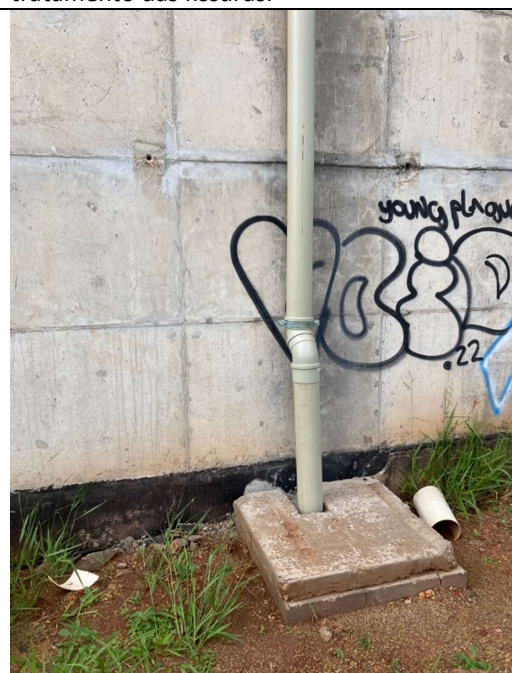
Tubulação a ser removida e reinstalada após tratamento das fissuras.
