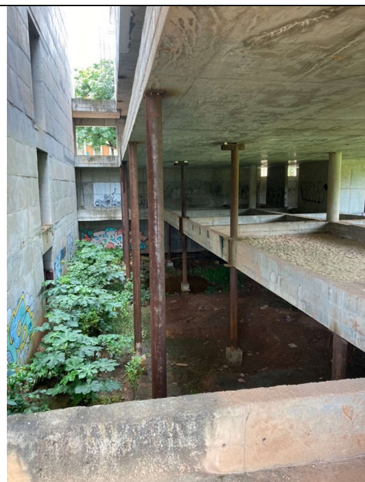
Colunas de perfil circular que receberão tratamento de superfície, fundo e pintura.
