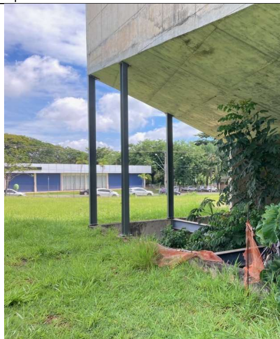
Reforços em perfil metálico W200 a serem removidos.
