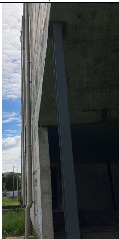
Reforços em perfil metálico W200 a ser removido.
