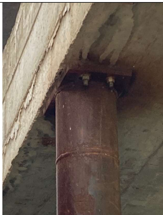
Coluna de perfil circular que receberá tratamento e pintura
