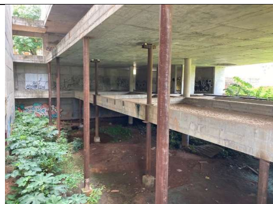
Colunas de perfil circular que receberão tratamento de superfície, fundo e pintura.
