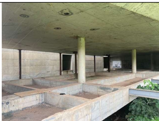
Ao fundo colunas de perfil circular que receberão tratamento de superfície, fundo e pintura.
