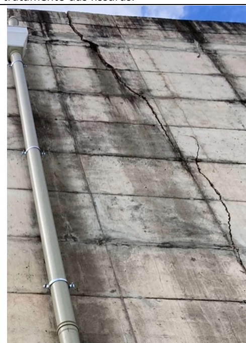
Um dos locais de fissura a receber tratamento e manta de fibra de carbono.
