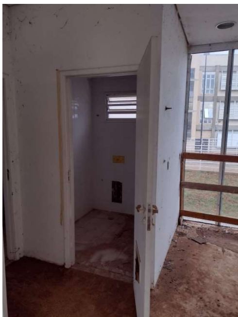
SANITÁRIOS PNE DO MEZANINO CONSTRUÍDOS DIFERENTES DO PROJETO
