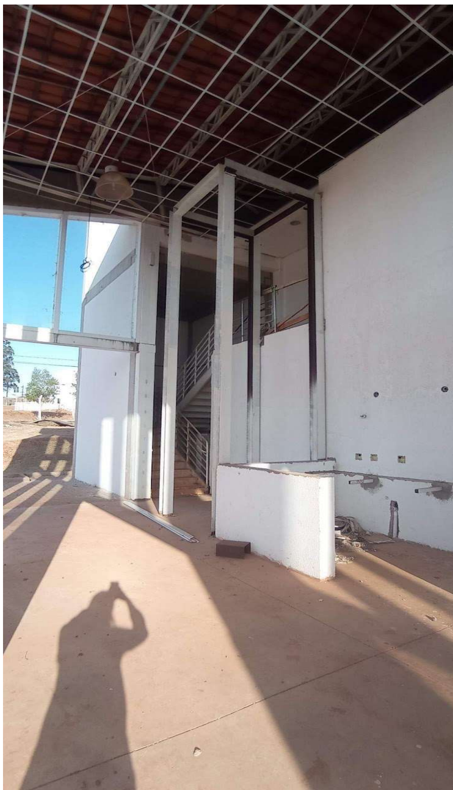
Estrutura metálica da plataforma elevatória a ser removida.
