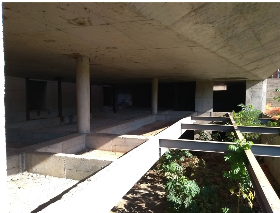
Vista do pavimento térreo e grelha para ventilação do subsolo
