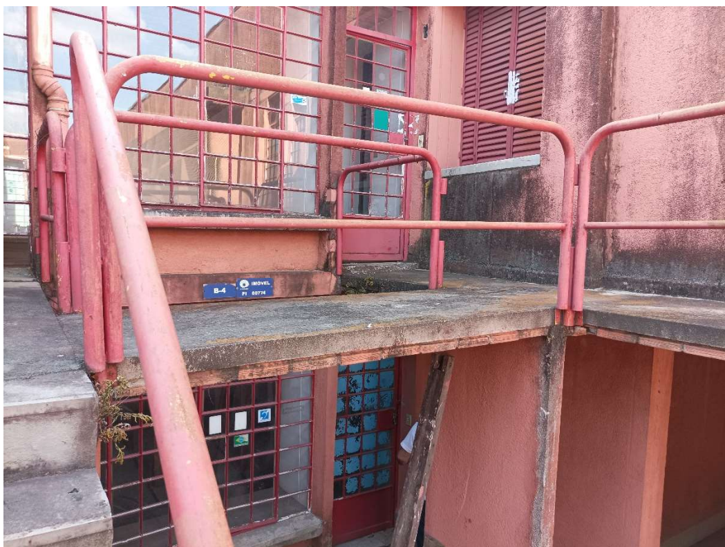
Casas B-4 e B-4a– caixilhos danificados devido a movimentação da estrutura.
