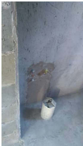
FOTO 28: Ponto de alimentação hidráulica para o lavatório do sanitário e caixa sifonada
