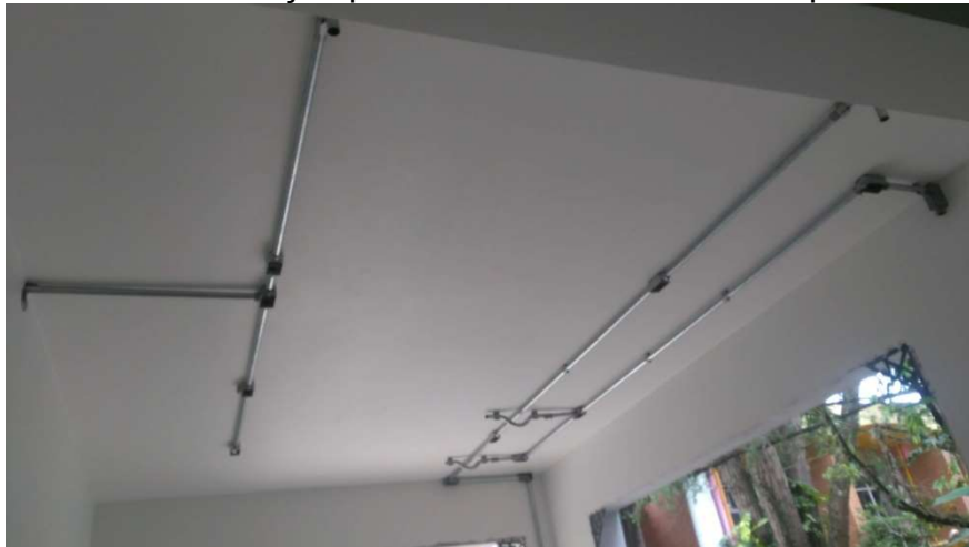
FOTO 26: Instalação parcial dos eletrodutos no 1º pavimento
