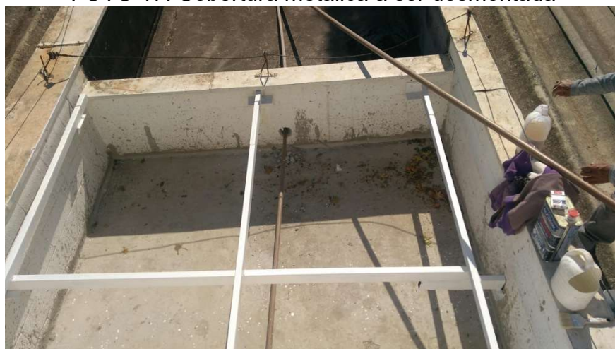
FOTO 17: Cobertura metálica a ser desmontada
