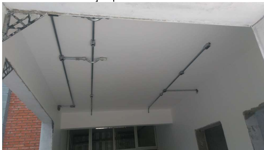
FOTO 25: Instalação parcial dos eletrodutos no térreo
