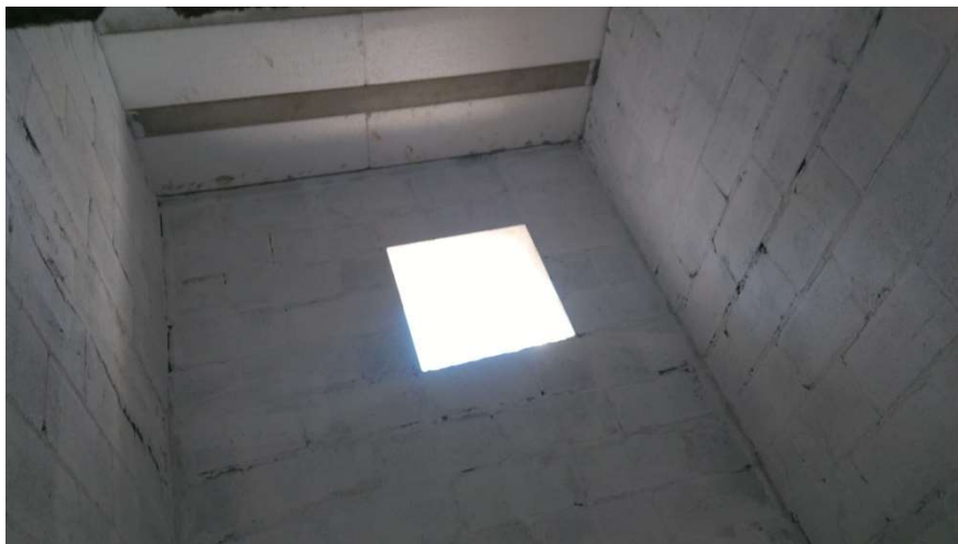
FOTO 23: Abertura para instalação de veneziana da ventilação da caixa de corrida do elevador
