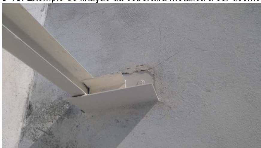
FOTO 18: Exemplo de fixação da cobertura metálica a ser desmontada
