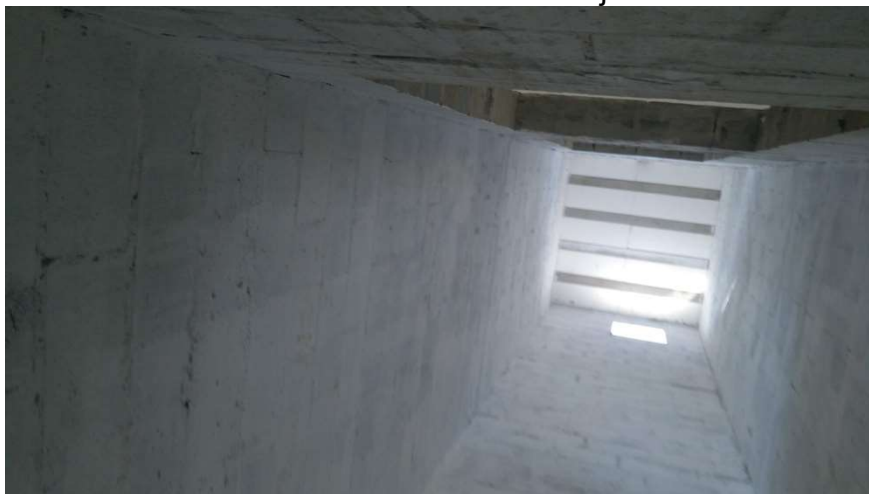
FOTO 14: Caixa de corrida do elevador e laje da caixa de corrida
