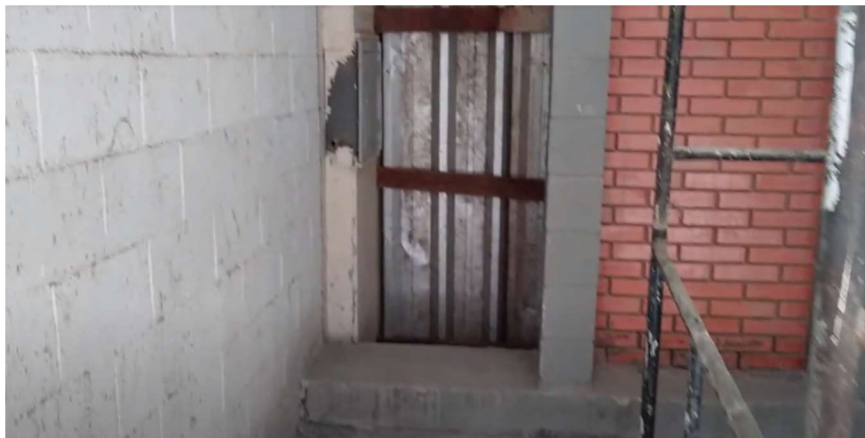
FOTO 33: Alvenaria e pilaretes a serem demolidos. Deverá ser dado acabamento na lateral do quadro.
