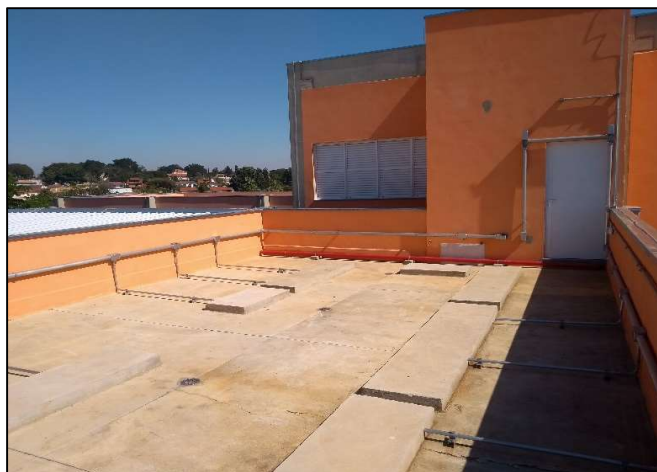
Fotos 66 e 67: Laje Impermeabilizada maq. Ar condicionado - Ala Direita - Cobertura
