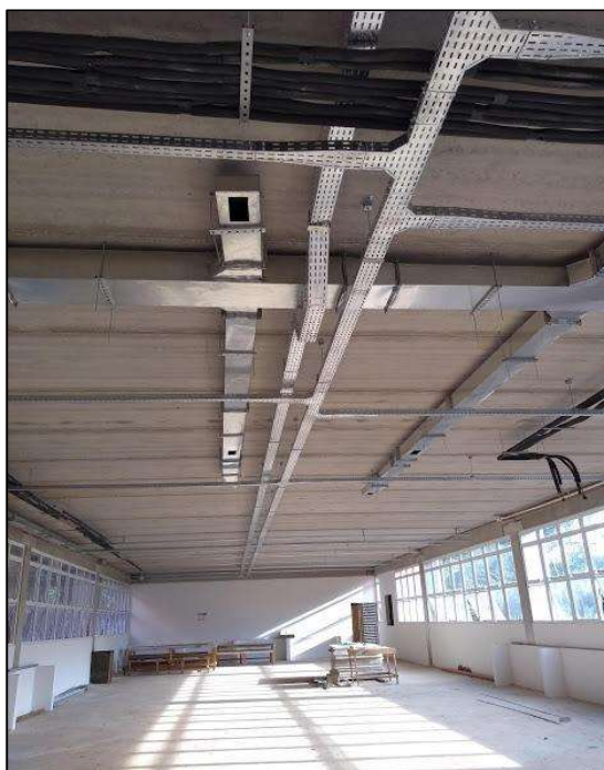
Foto 111: Dutos lado esquerdo (foto tirada antes de se executar forros e divisórias)
