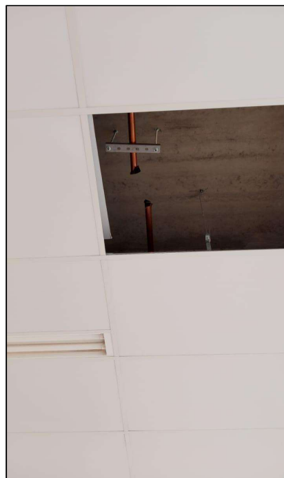
Foto 97: Coleção Úmida UE09 (Tubulação Interrompida)
