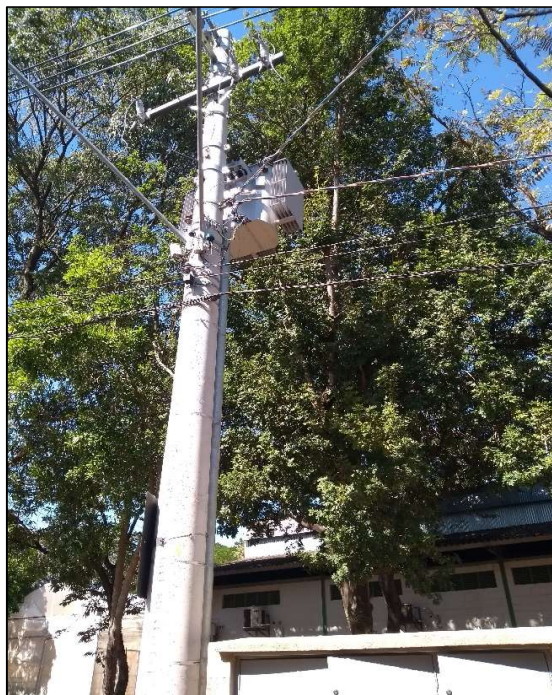
Foto 03: Transformador onde será feita interligação elétrica
