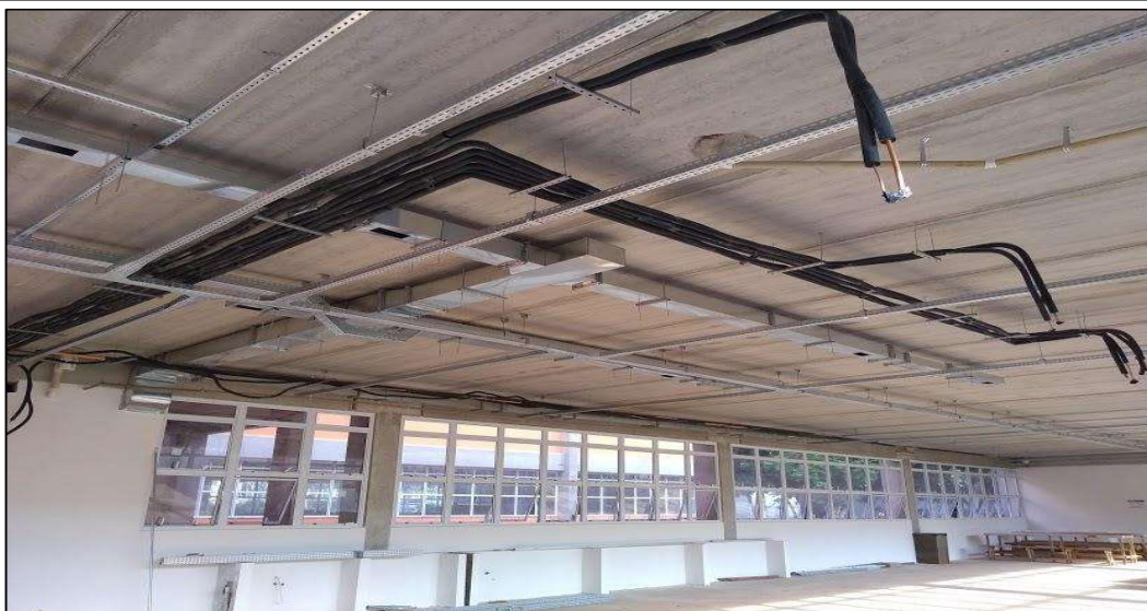
Foto 113: Dutos lado esquerdo (foto tirada antes de se executar forros e divisórias)
