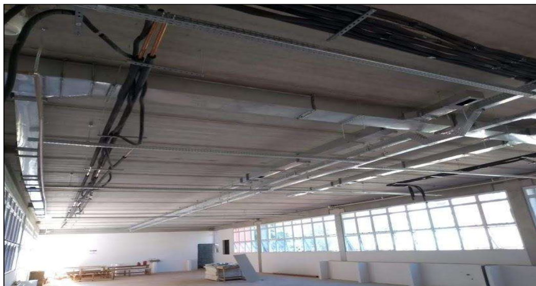
Foto 112: Dutos lado esquerdo (foto tirada antes de se executar forros e divisórias)
