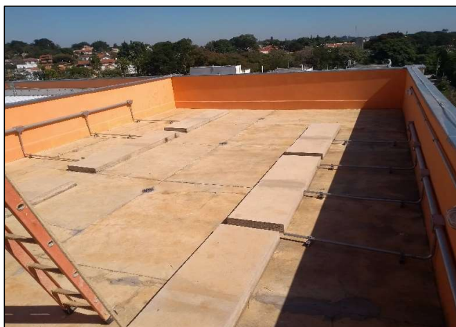
Foto 68: Laje Impermeabilizada maq. Ar condicionado - Ala Esquerda - Cobertura
