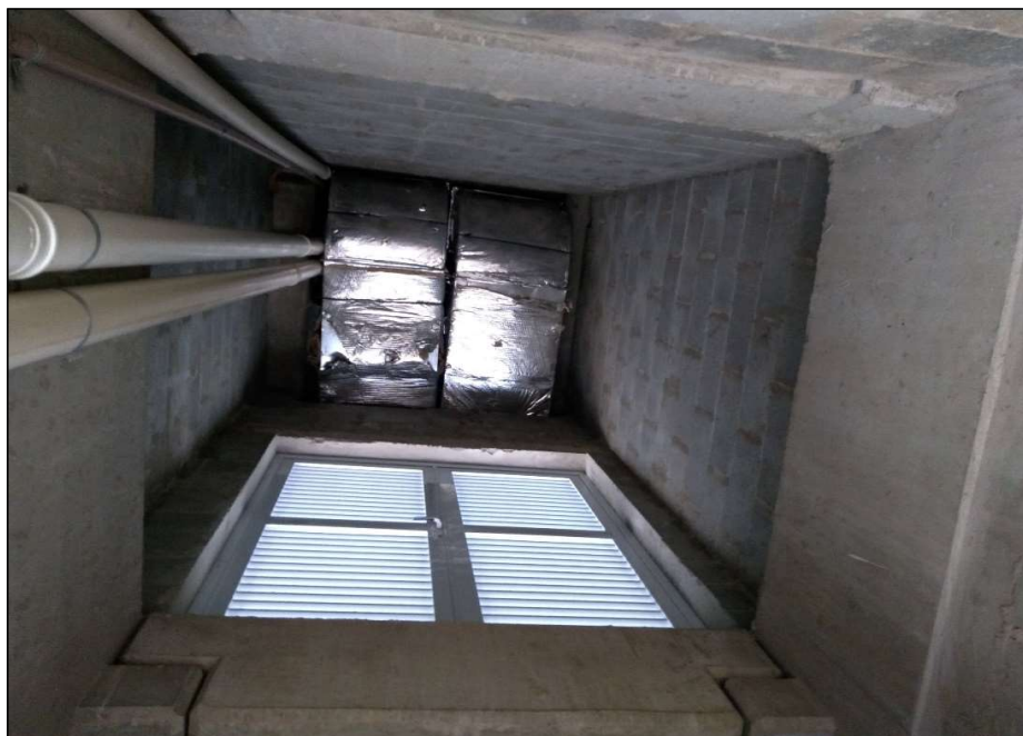
Foto 18: Vista interna shaft ala esquerda - Pav. Térreo - Dutos de climatização do 1º pavimento.
