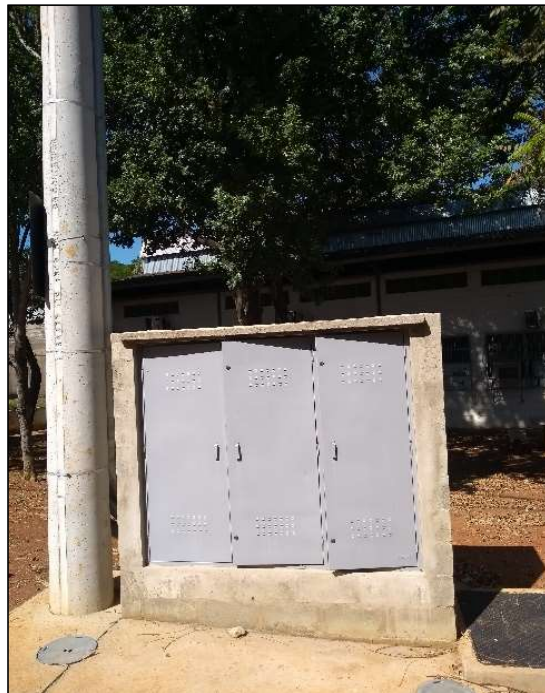
Foto 02: Quadro de medição a ser pintado
