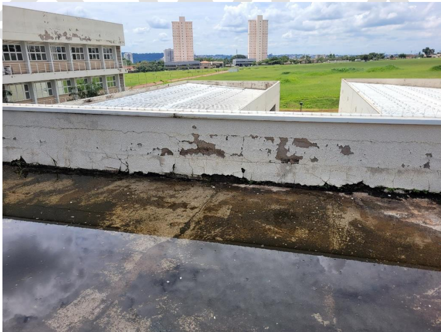
Imagem 7 – Barrilete, interligação Bloco 2 Empoçamento e rachaduras em platibandas.
