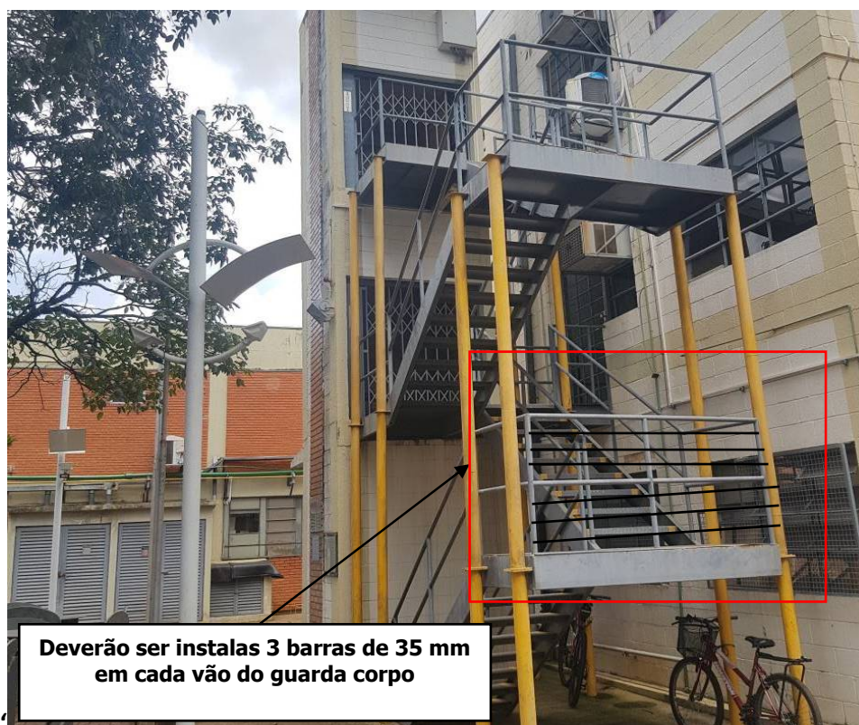
IMAGEM 04B: Detalhamento da adequação do guarda corpo que deverá ser executado.
