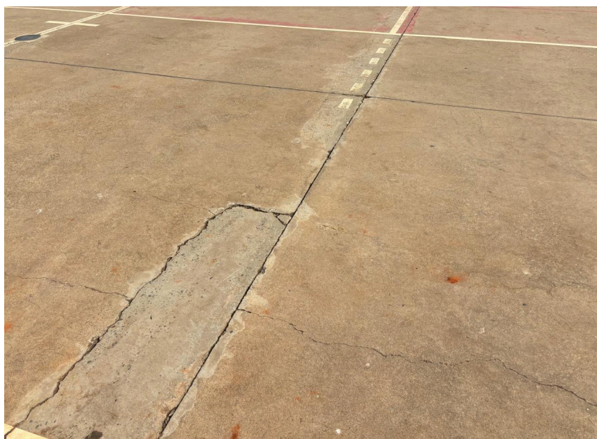
Figura 06. Piso com trincas e fissuras.
