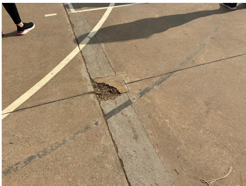
Figura 09. Trechos danificados do piso.
