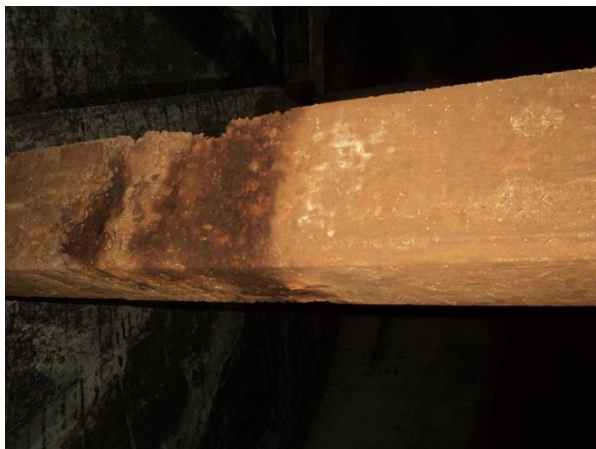
Figura 21. Ponto de perda do revestimento na base da coluna, sem a presença de problemas estruturais
