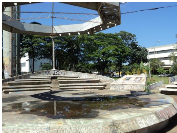
Figura 48. Detalhe da água parada sobre o teto da casa de bombas
