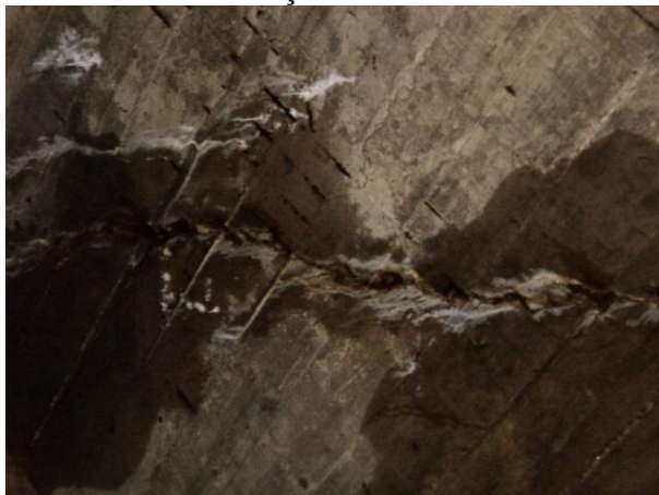
Figura 29. Trinca no teto (laje interna) com a presença de oxidação da armadura e carbonatação do concreto
