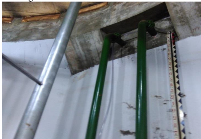
Figura 44. Vista das tubulações de entrada de água e extravasor de um reservatório
