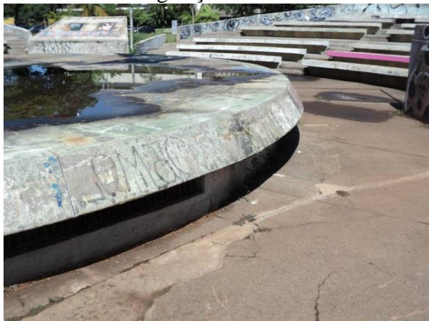
Figura 53. Presença de trinca e aparecimento de vegetação entre elas
