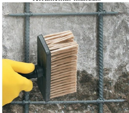
Figura 80. Remoção do revestimento até se expor todo concreto com o uso de ferramentas manuais
