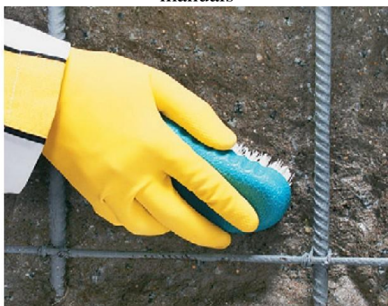
Figura 79. Remoção do revestimento até se expor todo concreto com o uso de ferramentas manuais
