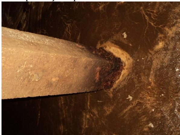
Figura 25. Vista da base de uma coluna com ponto de perda do revestimento, sem a presença de problemas estruturais
