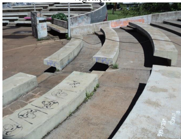
Figura 52. Presença de trinca na junção do degrau da arquibancada com aparecimento de vegetação
