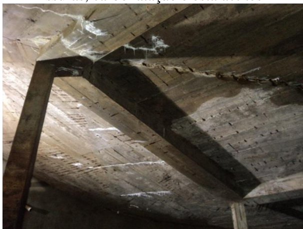
Figura 35. Visão geral do teto (laje interna) com armadura exposta com oxidação, fissuras, carbonatação e estalactites
