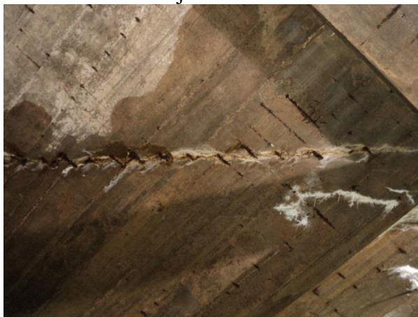
Figura 28. Trinca e presença de infiltração na laje interna
