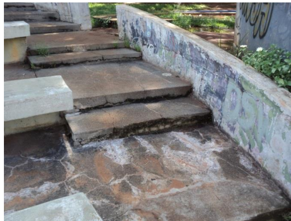
Figura 54. Presença de fissuras nos degraus da escada
