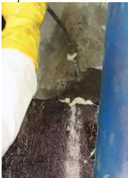
Figura 74. Detalhe da aplicação do poliuretano hidroativado
