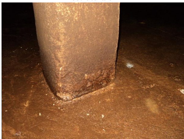
Figura 16. Ponto de perda do revestimento na base da coluna, sem a presença de problemas estruturais
