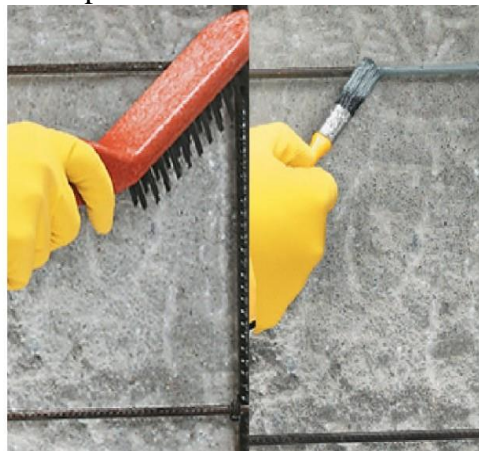
Figura 82. Limpeza de toda a oxidação das barras de aço restantes, por processo mecânico de lixamento manual e aplicação de produto inibidor de corrosão
