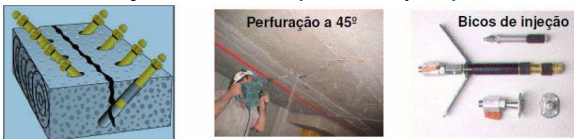
Figura 69. Detalhe de colocação dos bicos de perfuração
