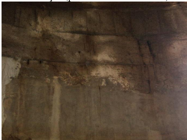
Figura 33. Presença de infiltração nas juntas de dilatação (paredes internas laterais)
