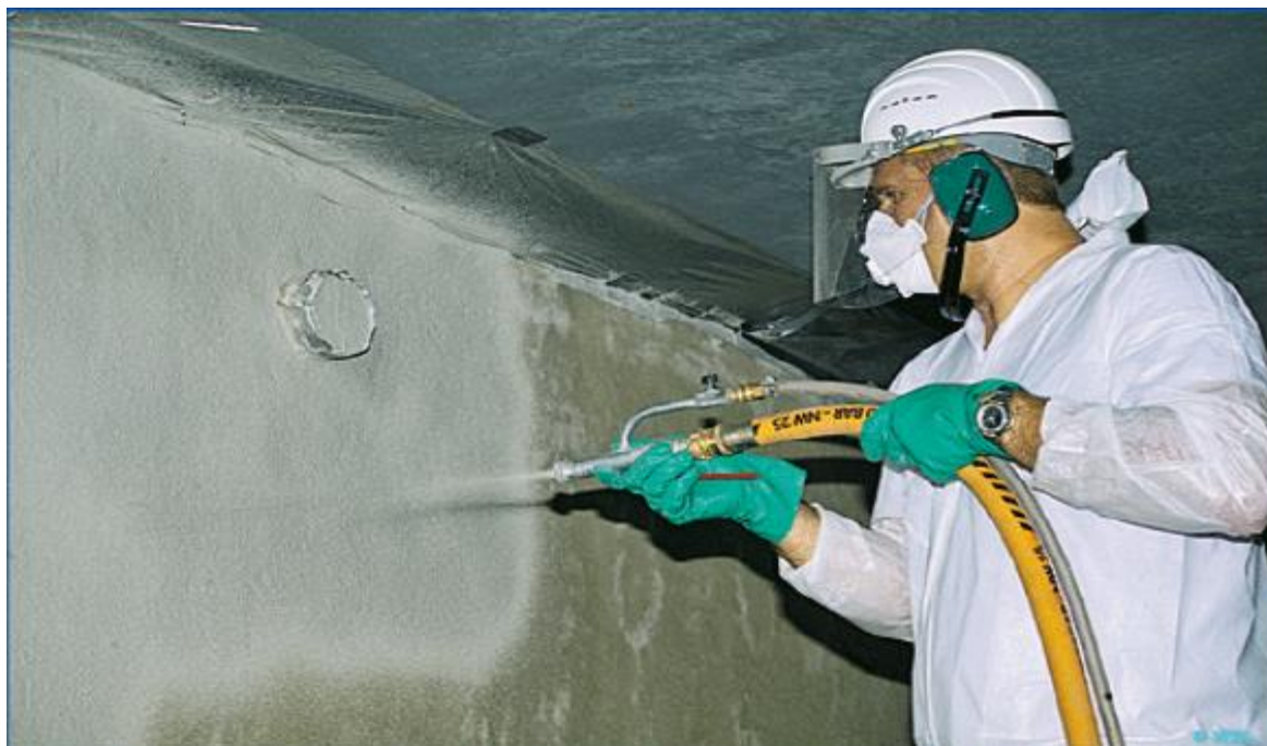
Figura 85. Exemplo de aplicação de impermeabilizante por projeção proposto no presente trabalho
