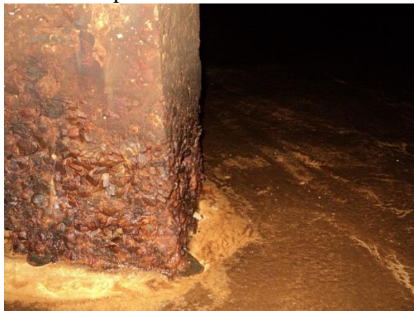
Figura 26. Detalhe de uma coluna com ponto de perda do revestimento, sem a presença de problemas estruturais
