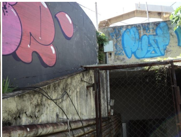
Figura 46. Rampa de acesso a casa de bombas, detalhe de infiltração nas paredes externas dos reservatório enterrados
