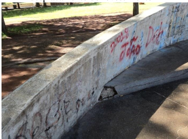
Figura 63. Presença de trinca no degrau e deslocamento do revestimento
