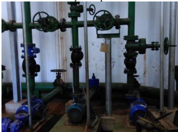
Figura 43. Vista dos conjuntos motor-bomba e infiltração na parede ao fundo
