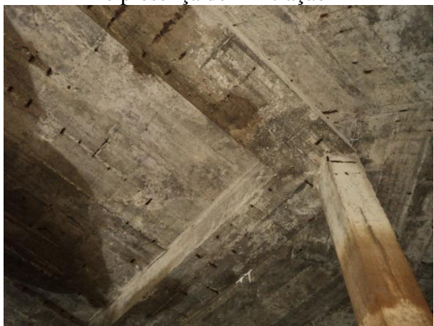
Figura 36. Vista da junção de Colunas e Viga e presença de infiltração
