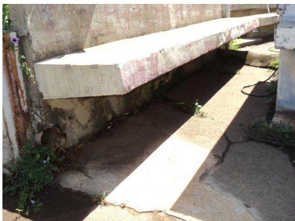
Figura 61. Presença de trincas na laje
