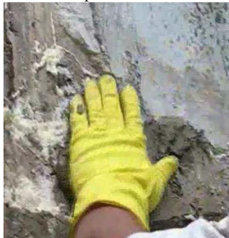
Figura 77. Reparo com argamassa cimentícia polimérica
