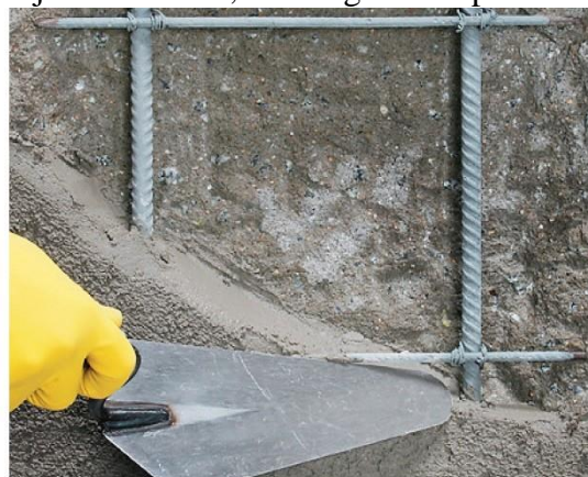
Figura 84. Reconstituir a espessura do concreto de acordo com o determinado no projeto estrutural, com argamassa polimérica
