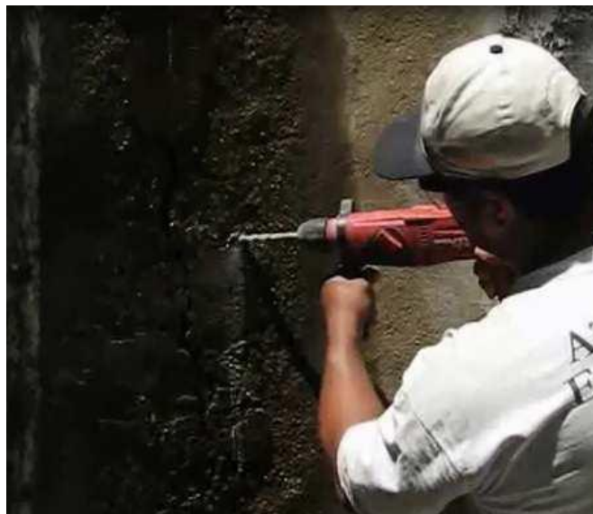
Figura 71. Perfuração para colocação dos bicos de injeção 45° para aplicação do Poliuretano Hidroativado
