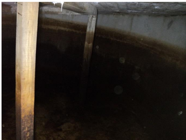
Figura 27. Vista das colunas sem presença de danos estruturais, apenas perda de revestimento da estrutura
