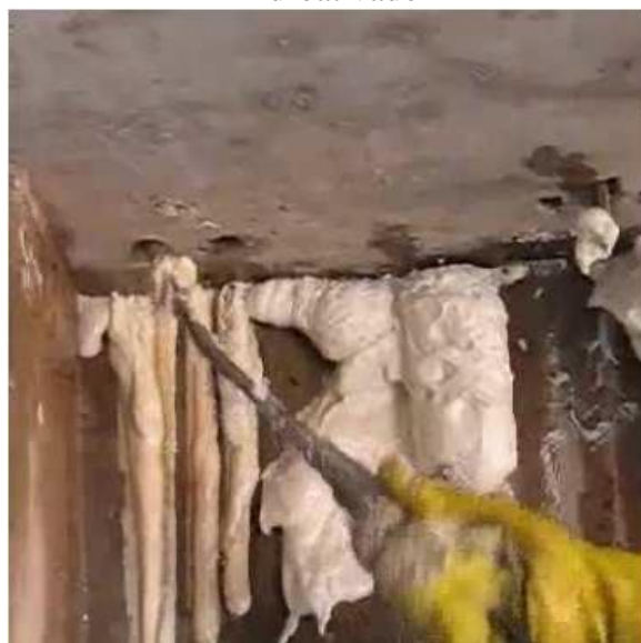
Figura 75. Detalhe da espuma de poliuretano hidroativado
