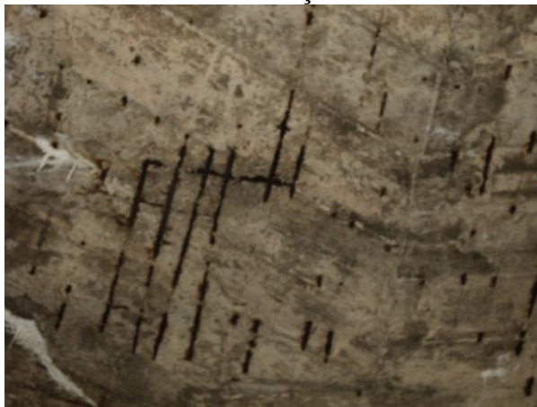
Figura 30. Armadura exposta e com presença de oxidação
