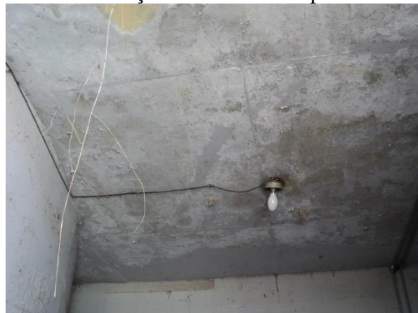
Figura 50. Presença de carbonatação no teto e infiltração no local da lâmpada
