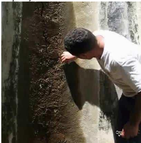
Figura 70. Marcação dos Furos para aplicação do Poliuretano Hidroativado
