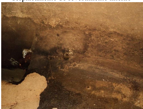
Figura 16. Ponto de perda do revestimento na base da coluna, sem a presença de problemas estruturais
