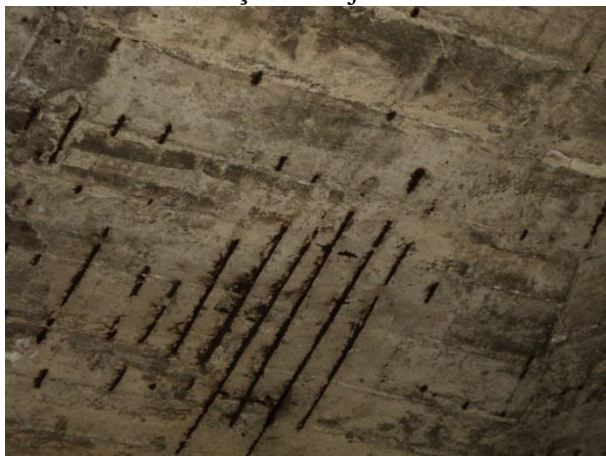
Figura 31. Armadura exposta e com presença de oxidação na laje interna
