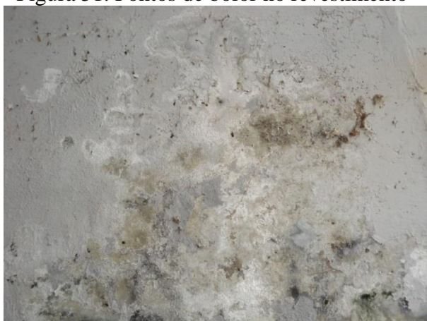
Figura 51. Pontos de bolor no revestimento
