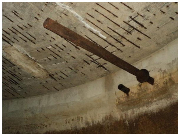
Figura 13. Tubulação de entrada de água oxidada
