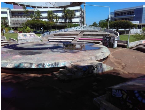
Figura 47. Vista com pontos de água parada na laje de cobertura dos reservatórios e casa de bombas
