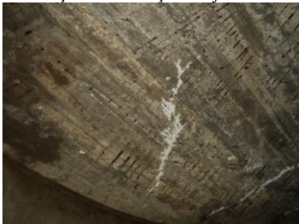
Figura 5. Pontos de armadura exposta com oxidação e carbonatação na laje interna
