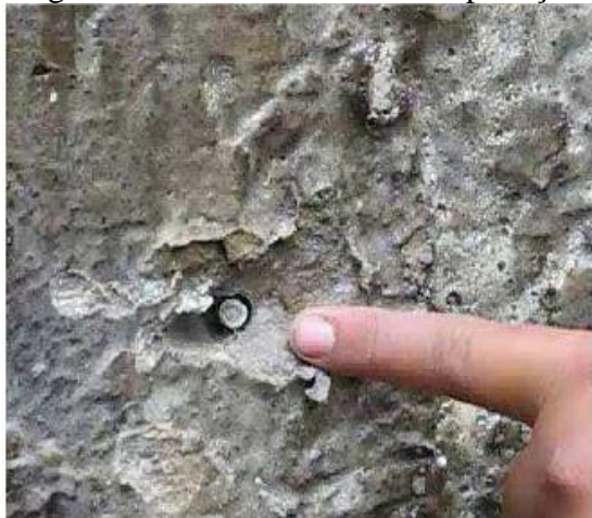
Figura 76. Retirada do bico de aplicação
