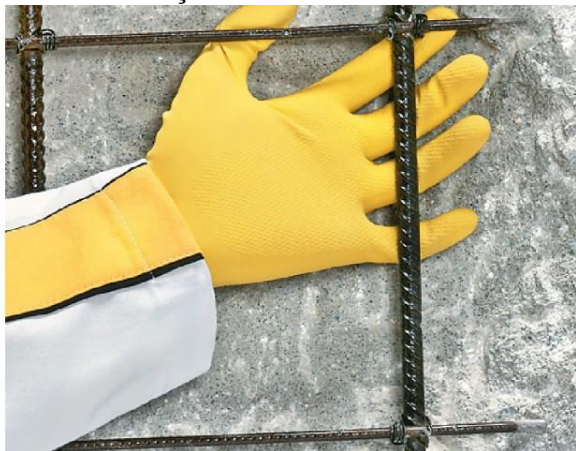
Figura 81. As armaduras deverão ser “liberadas” do concreto, por processo de corte e escarificação com ferramentas manuais
