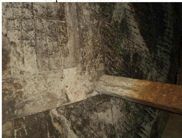
Figura 20. Armadura exposta no teto (laje interna) com oxidação e coluna sem presença de problemas estruturais
