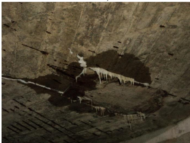
Figura 32. Pontos de fissura, deslocamento, infiltração e presença de estalactites (laje interna)
