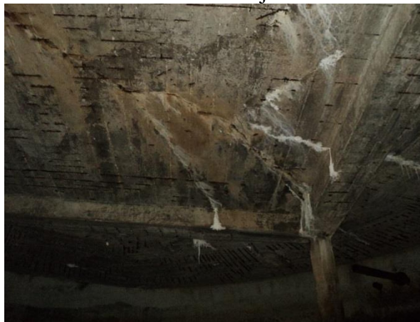
Figura 6. Pontos de carbonatação e formação de estalactites na laje interna
