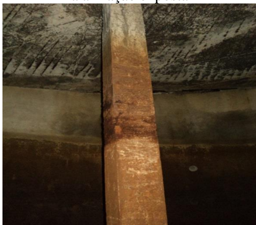
Figura 19. Vista de coluna e laje interna com a armadura exposta
