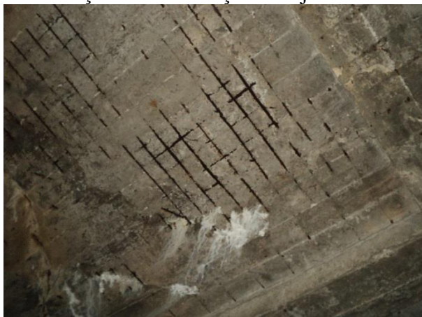
Figura 7. Pontos de armadura exposta com oxidação e carbonatação na laje interna
