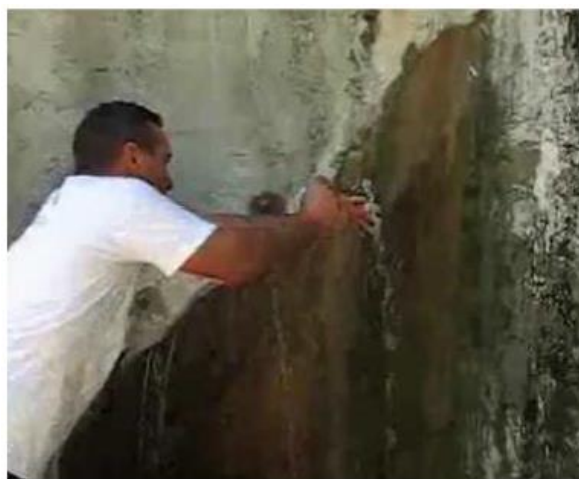
Figura 72. Colocação dos bicos ao longo das fissuras para aplicação do Poliuretano Hidroativado
