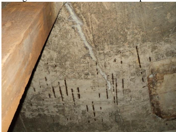
Figura 23. Pontos de armadura exposta
