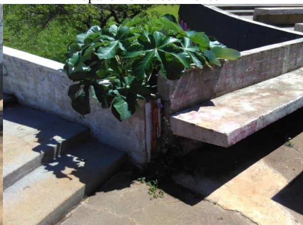
Figura 64. Presença de trinca e local com reparo no revestimento
