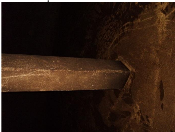
Figura 9. Coluna interna sem a presença de problemas estruturais
