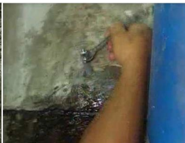
Figura 73. Aperto dos bicos para aplicação do Poliuretano Hidroativado
