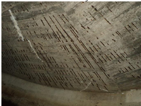
Figura 8. Pontos de carbonatação e formação de estalactites na laje interna
