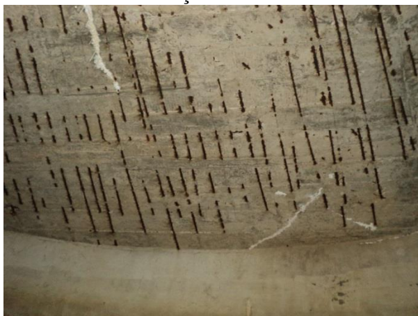
Figura 12. Muitos pontos de armadura expostos no teto com oxidação e pontos de carbonatação do concreto
