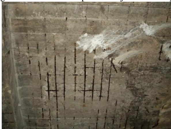
Figura 11. Armadura exposta na laje com oxidação
