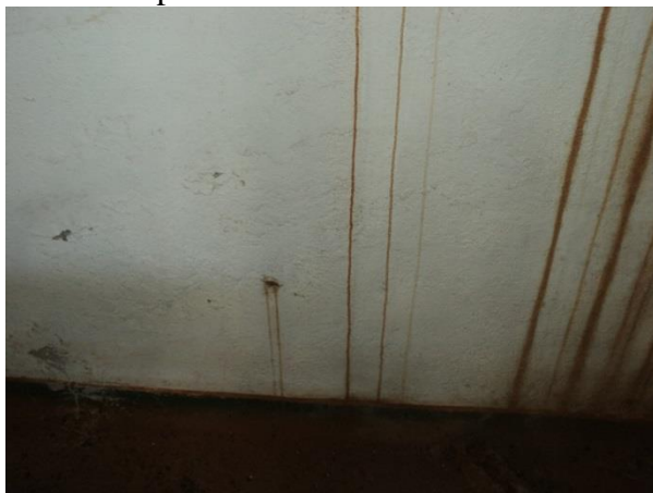
Figura 45. Marca de pontos de infiltração nas paredes da casa de bombas
