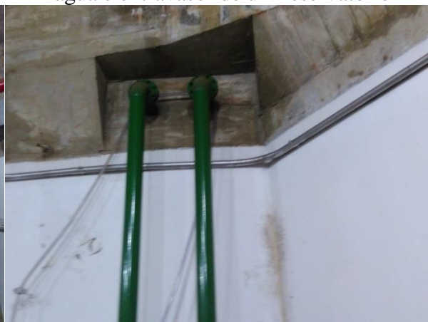
Figura 42. Vista das tubulações de entrada de água e extravasor de um reservatório
