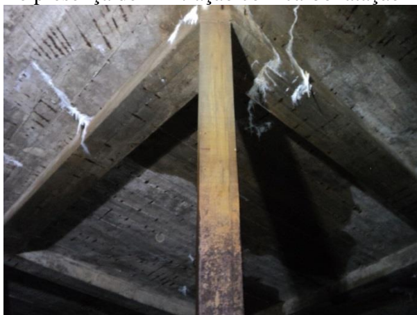
Figura 38. Vista da junção de Colunas e Viga e presença de infiltração com carbonatação
