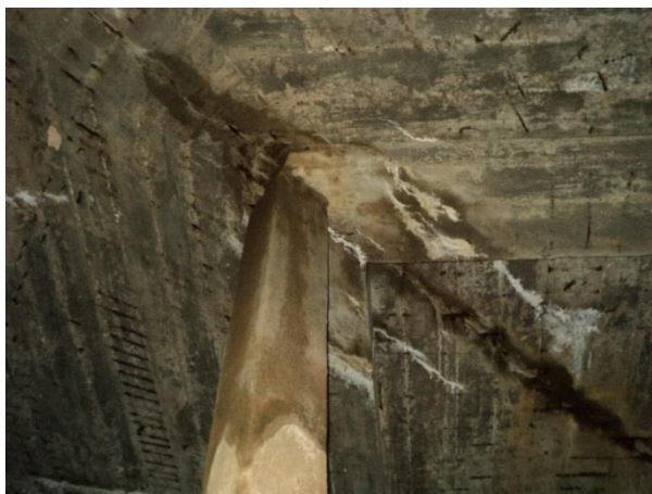
Figura 18. Pontos de infiltração na junção das paredes internas com o teto do reservatório
