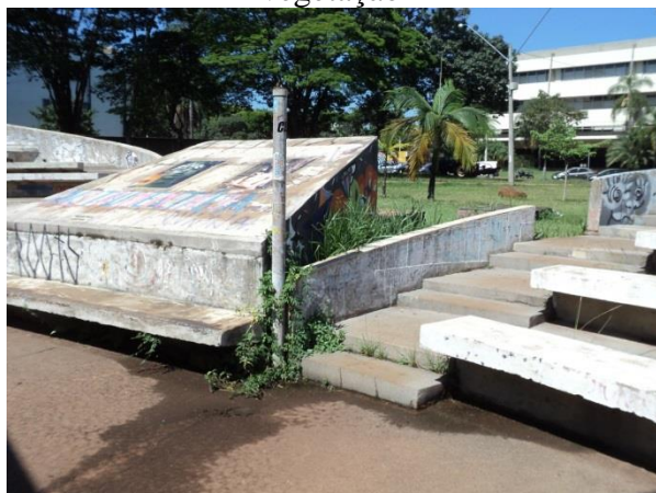
Figura 56. Presença de água e crescimento de vegetação
