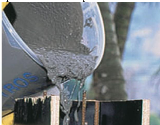
Figura 83. Preparo da argamassa polimérica para reconstituir a espessura do concreto
