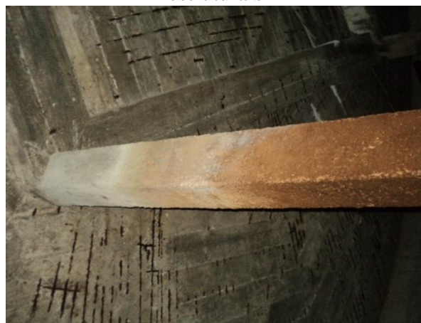
Figura 17. Armadura exposta na laje com oxidação e coluna sem presença de problemas estruturais
