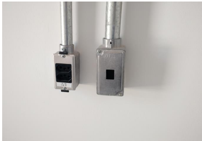
FOTO 72: Padrão de porta equipamento para RJ45 em condutele
