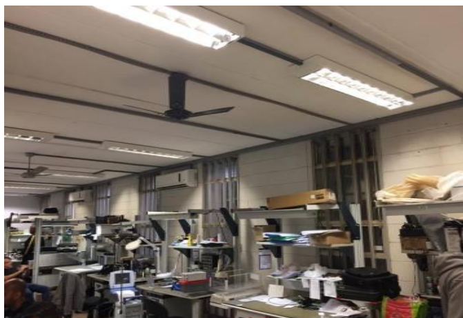
FOTO 60: Canaletas, ventiladores, luminárias e ares-condicionados a serem removidos da área da reforma do térreo. O mobiliário e os equipamentos serão removidos pela Unidade.
