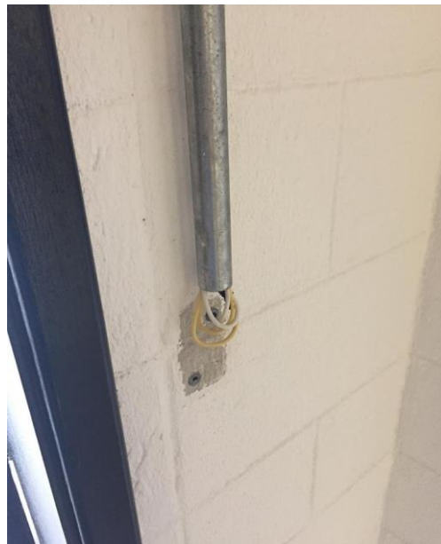
FOTO 28: Instalação de Conduteira na porta de acesso à Circulação, 2º Pavimento
