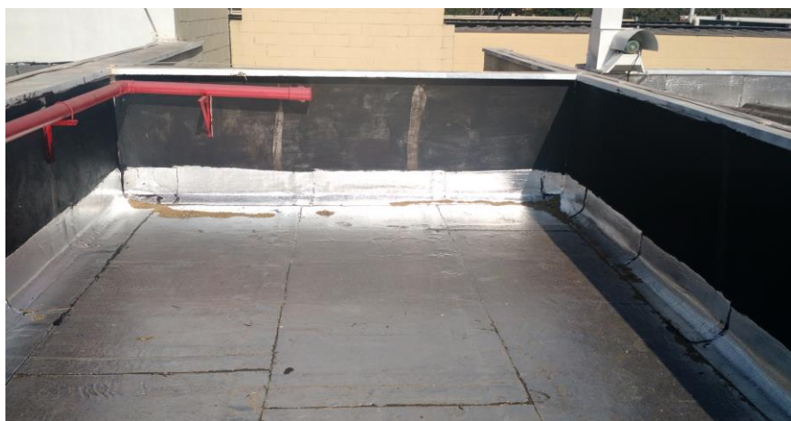
FOTO 75: Cobertura da escada antiga, onde deverá ser reformada a impermeabilização
