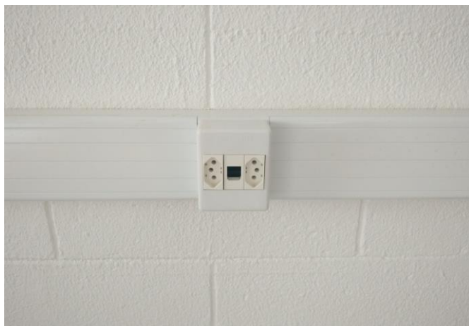
FOTO 71: Padrão de porta equipamento para RJ45 em canaleta
