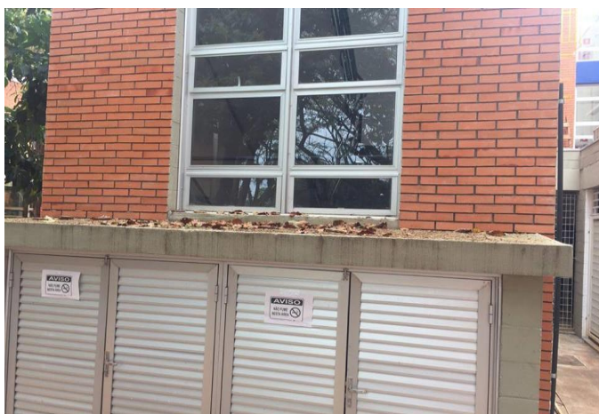
FOTO 15: Cobertura do abrigo de gases a ser impermeabilizada
