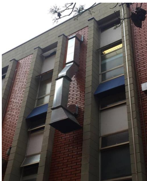
FOTO 9: Duto de ventilação externo a complementar, acima da base para Caixa de Ventilação
