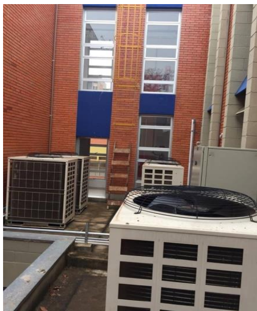
FOTO 30: Dreno de ar condicionado a ser prolongado até o ralo, na área das condensadoras
