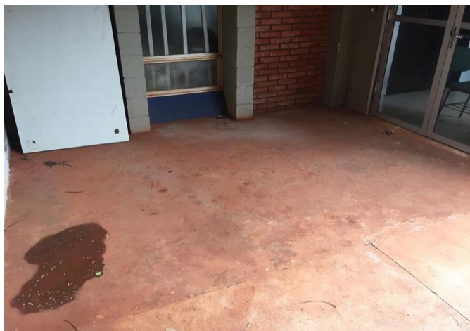
FOTO 69: Área do terraço coberto cujo piso deverá ser limpo e receberá pintura epóxi conforme memorial descritivo
