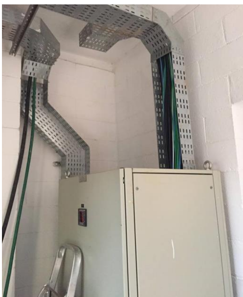
FOTO 53: Canaletas do PGBT - Passagem dos alimentadores do QFAC e dos quadros do térreo no hall do elevador do térreo
