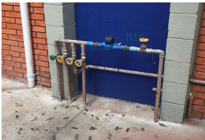
FOTO 17: Cavalete para hidrômetro, onde deverá ser instalada torneira de jardim
