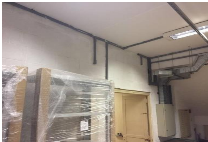
FOTO 55: Remoção das tubulações e canaletas de PVC que serão desativadas - reforma na recepção
