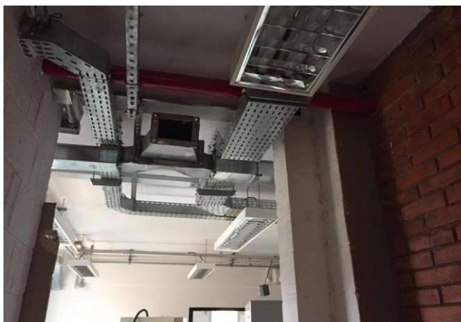
FOTO 10: Ponto de interligação do duto de ventilação do térreo, na área de solda
