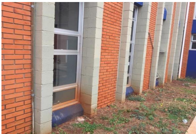
FOTO 5: Paredes externas da área da mecânica, as quais deverão ser Impermeabilizadas
