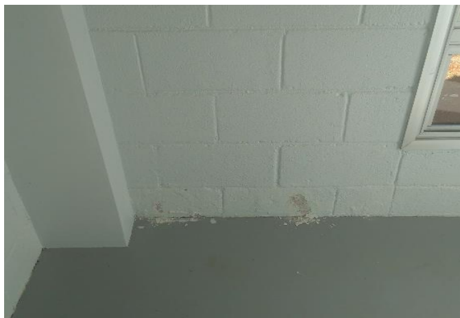
FOTO 6: Parede na Sala de Manutenção, com pintura descascando
