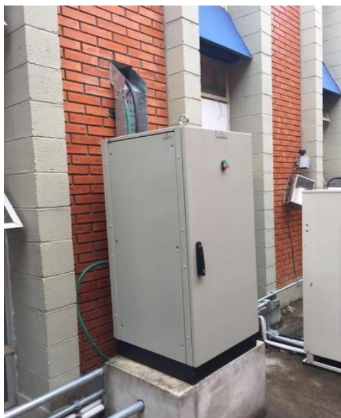
FOTO 29: QFAC - Construção de cobertura para quadro do ar-condicionado e finalização da instalação - Área das Condensadoras
