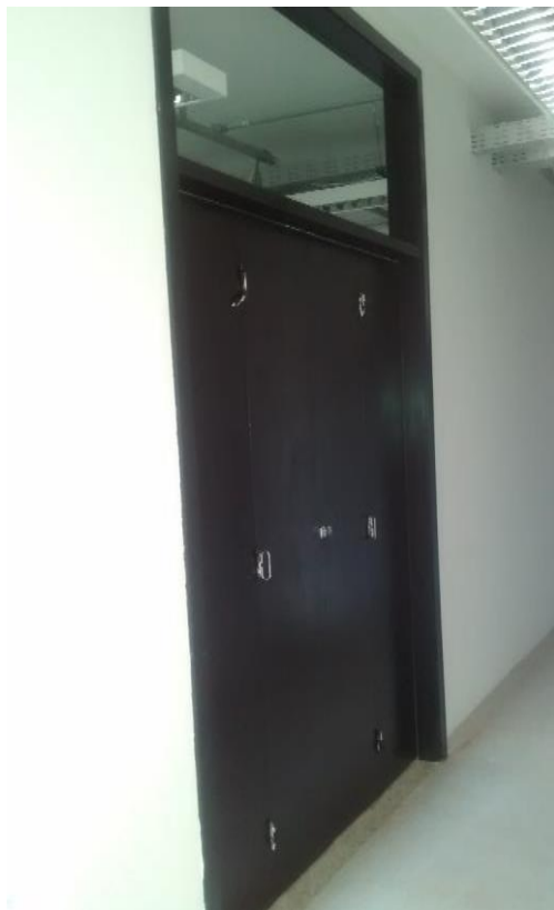
FOTO 33: Porta camarão da sala de reuniões do 1º andar, onde deverá ser instalado puxador para abertura pelo lado interno
