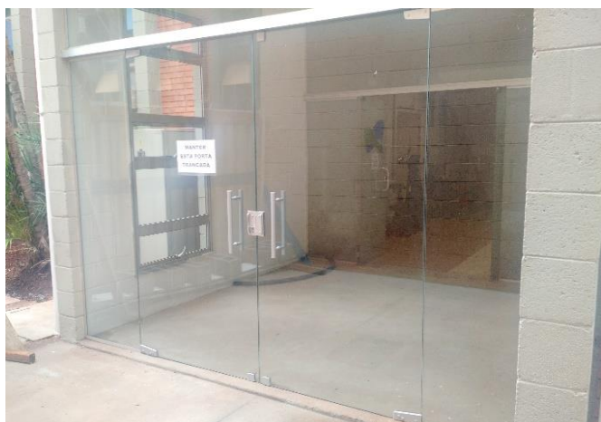
FOTO 51: Porta de vidro a ser retirada para a instalação de soleira. A qual deve ser reinstalada após o serviço, na entrada principal do prédio
