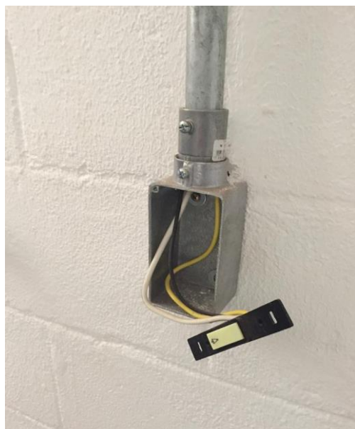
FOTO 23: Instalação de minuteria nas escadas e colocação do espelho do condutele.
