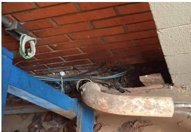
FOTO 68: Local na área da solda onde deverá ser removido os cabos antigos e complementado o piso em concreto
