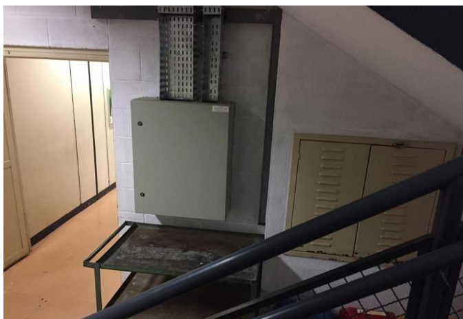
FOTO 47: Finalização da instalação do quadro elétrico do térreo
