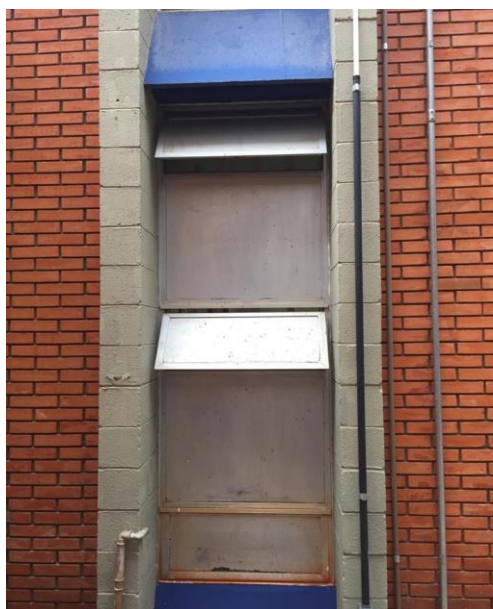
FOTO 40: Esquadrias a serem substituídas - Reforma do térreo
