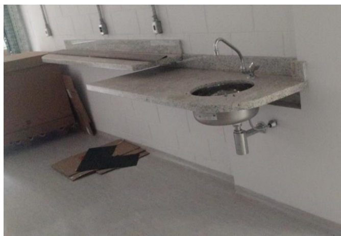
FOTO 38: Bancada BC06, no hall do elevador do 1º pavimento, onde deverá ser finalizada a instalação de esgoto
