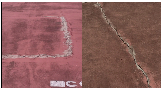
Figura 1: Fissuras e rachaduras encontradas nas quadras.
