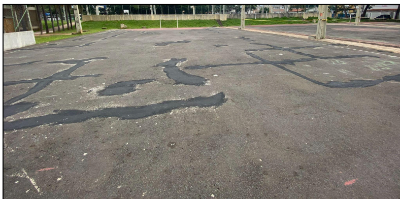
Figura 4: Desgaste das quadras.
