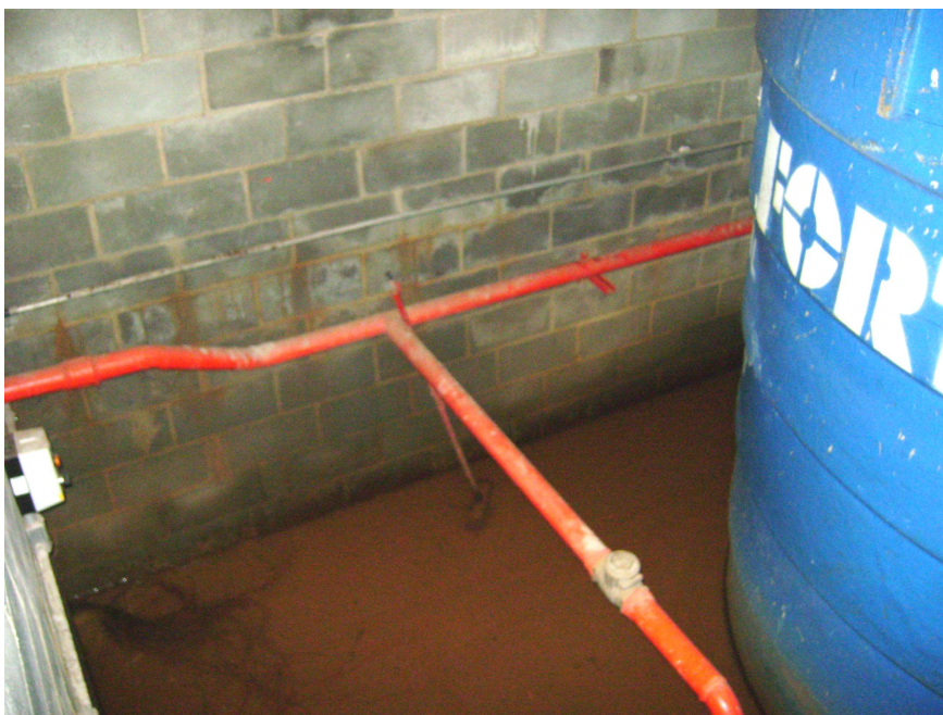
Foto 24 – Detalhe do barrilete do reservatório para incêndio.
