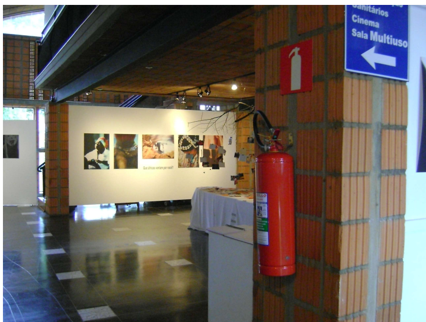
Foto 08 – Extintor de incêndio / instalado no pilar do salão de exposições.
