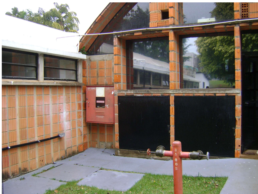
Foto 20 – Detalhe de hidrante na área externa.
