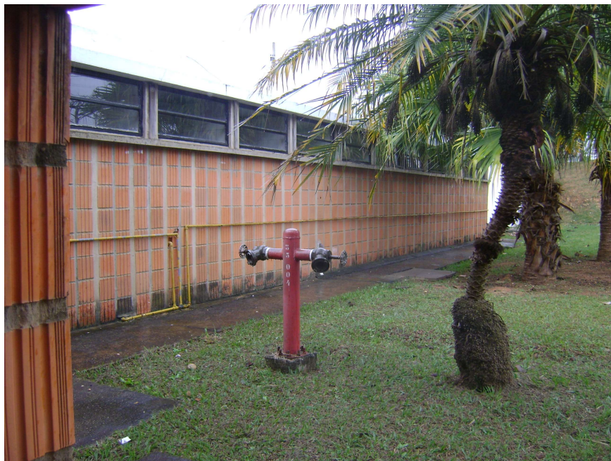
Foto 19 – Detalhe de hidrante na área externa.
