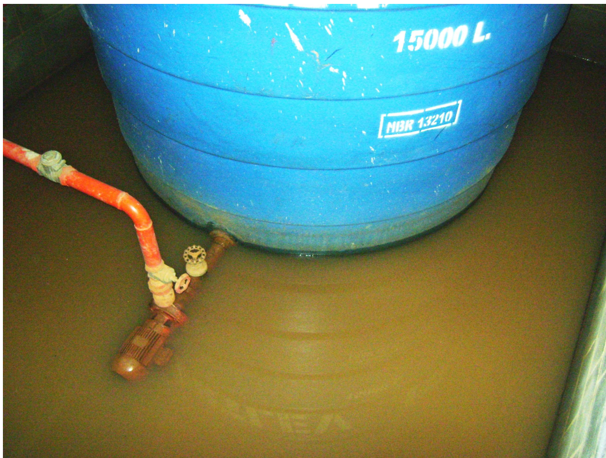
Foto 25 – Água residual (possivelmente do lençol freático) – altura 10 cm.
