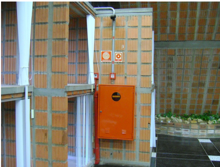
Foto 21 – Abrigo de mangueira e hidrante / sala multiuso.
