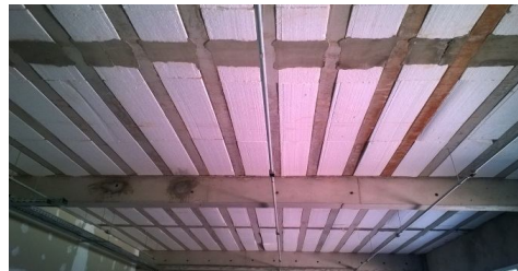
Foto 115 e 116 : SALA MULTIUSO PISO NO CONTRAPISO E TETO SEM FORRO.
