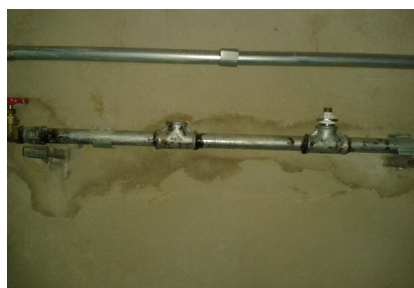
Foto 149 e 150 : DETALHE TUBULAÇÕES E PONTO INCÊNDIO EXTERNO (RUA).
