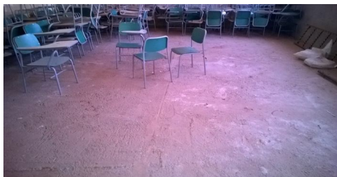
Foto 115 e 116 : SALA MULTIUSO PISO NO CONTRAPISO E TETO SEM FORRO.
