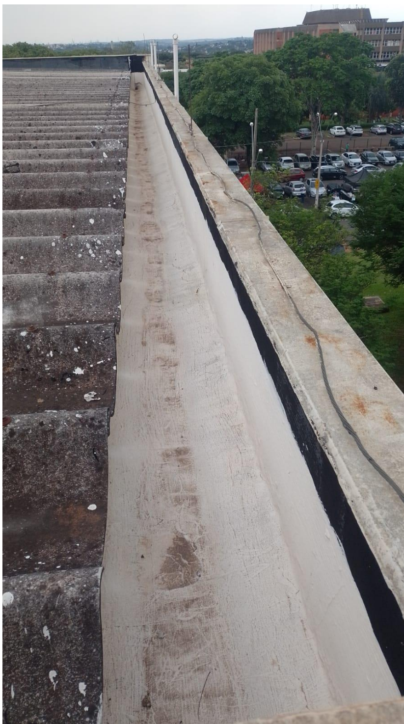
Foto 15: Vista das vigas calha.
