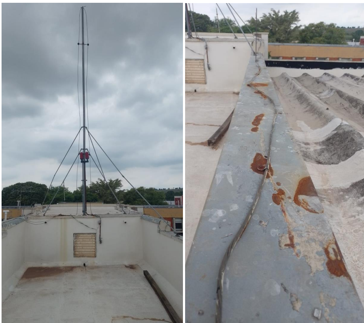
Fotos 5 e 6: As interferências consistem em cordoalhas de SPDA, antenas, eletrodutos, cabos e quaisquer outros objetos na frente de trabalho.
