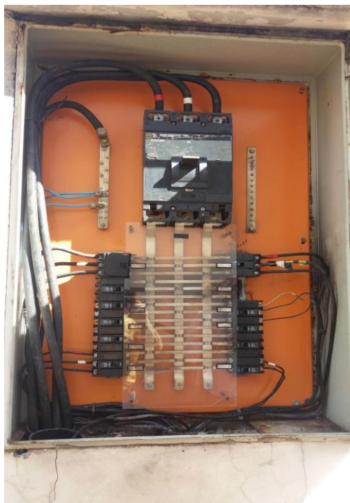
Foto 13: Quadro QGBT do posto de transformação à desativar.
