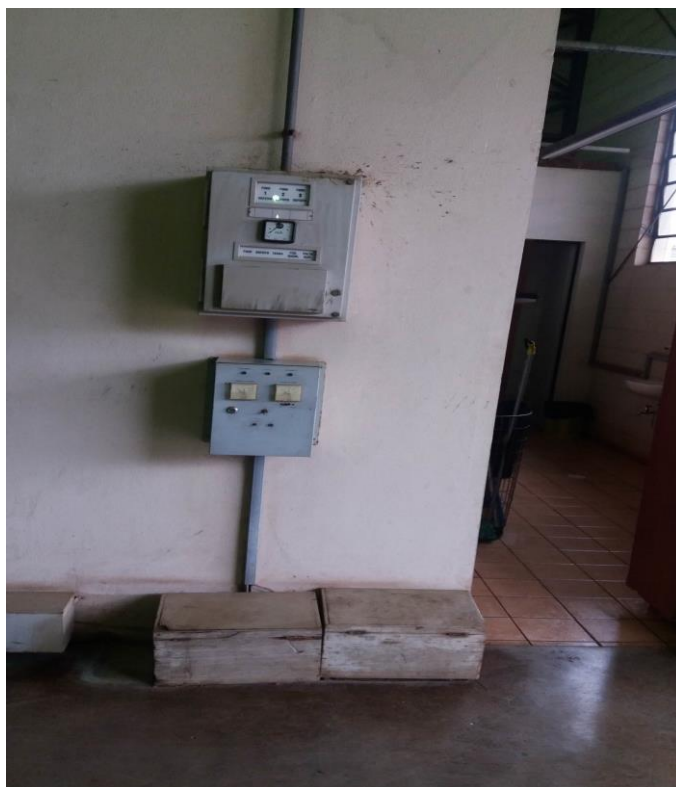
Foto 05: Central de alarme de incêndio a desativar/retirar.
